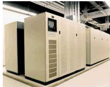
Zentrale monolithische USV
